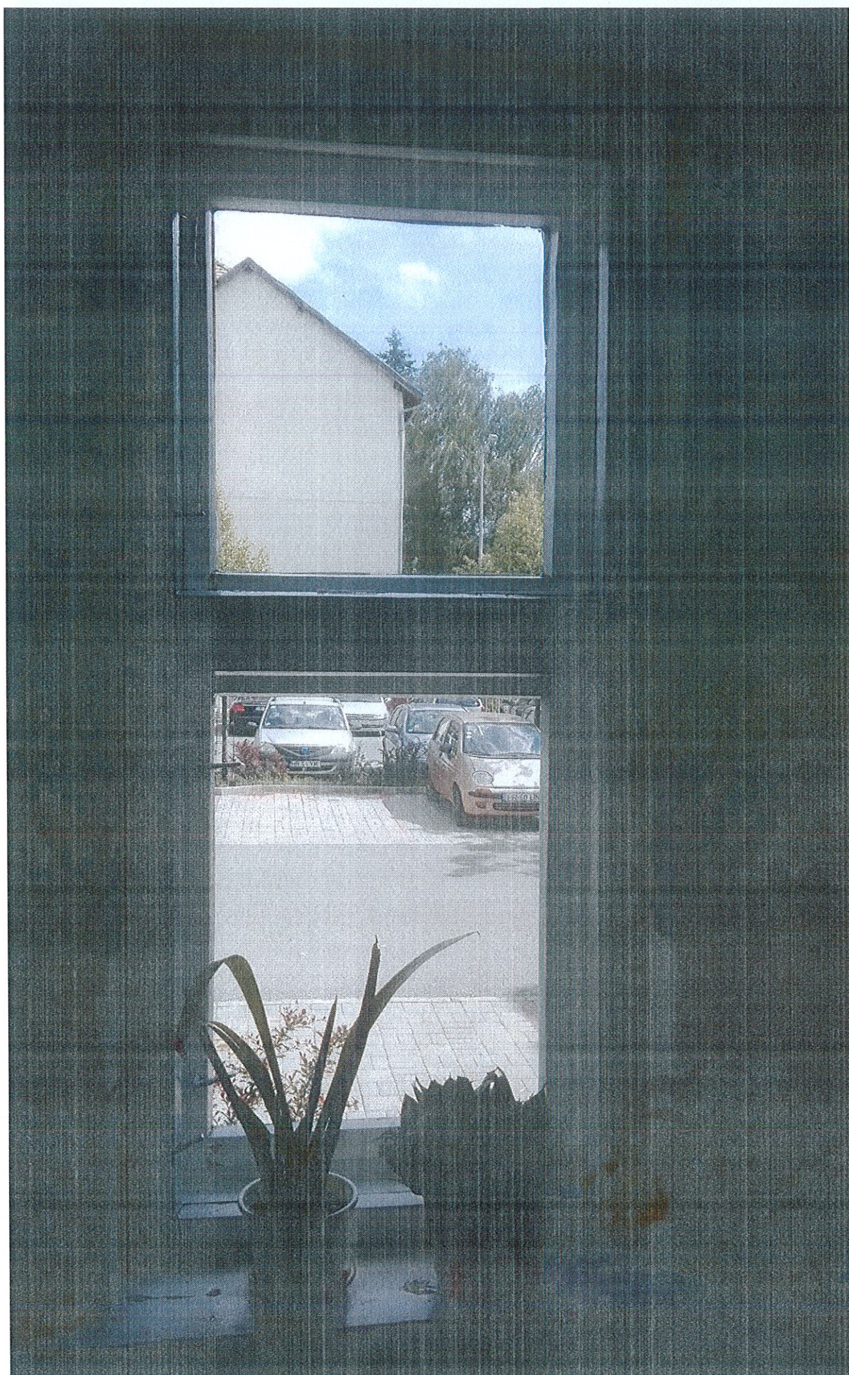
Fereastra tip 3: geamuri cu 2 ochiuri cu următoarele dimensiuni maxime măsurate: lățime de 71,5 cm și cu înălțime de 173,5 cm, în total sunt 6 buc./clădire.
