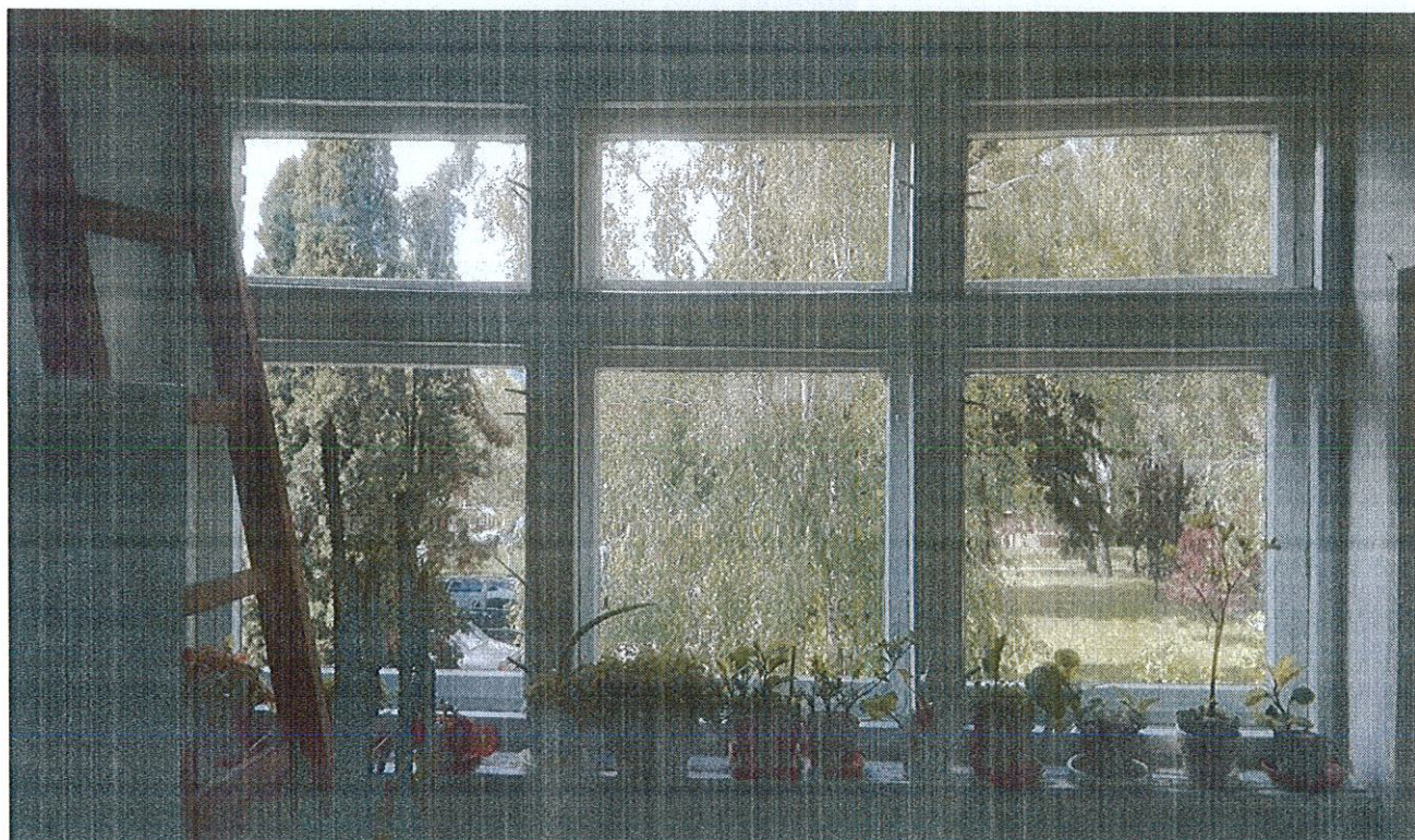
Fereastra tip 5: geam triplu cu lungime totală de 264 cm și înălțime de 150 cm, în total există 1 buc./clădire.
