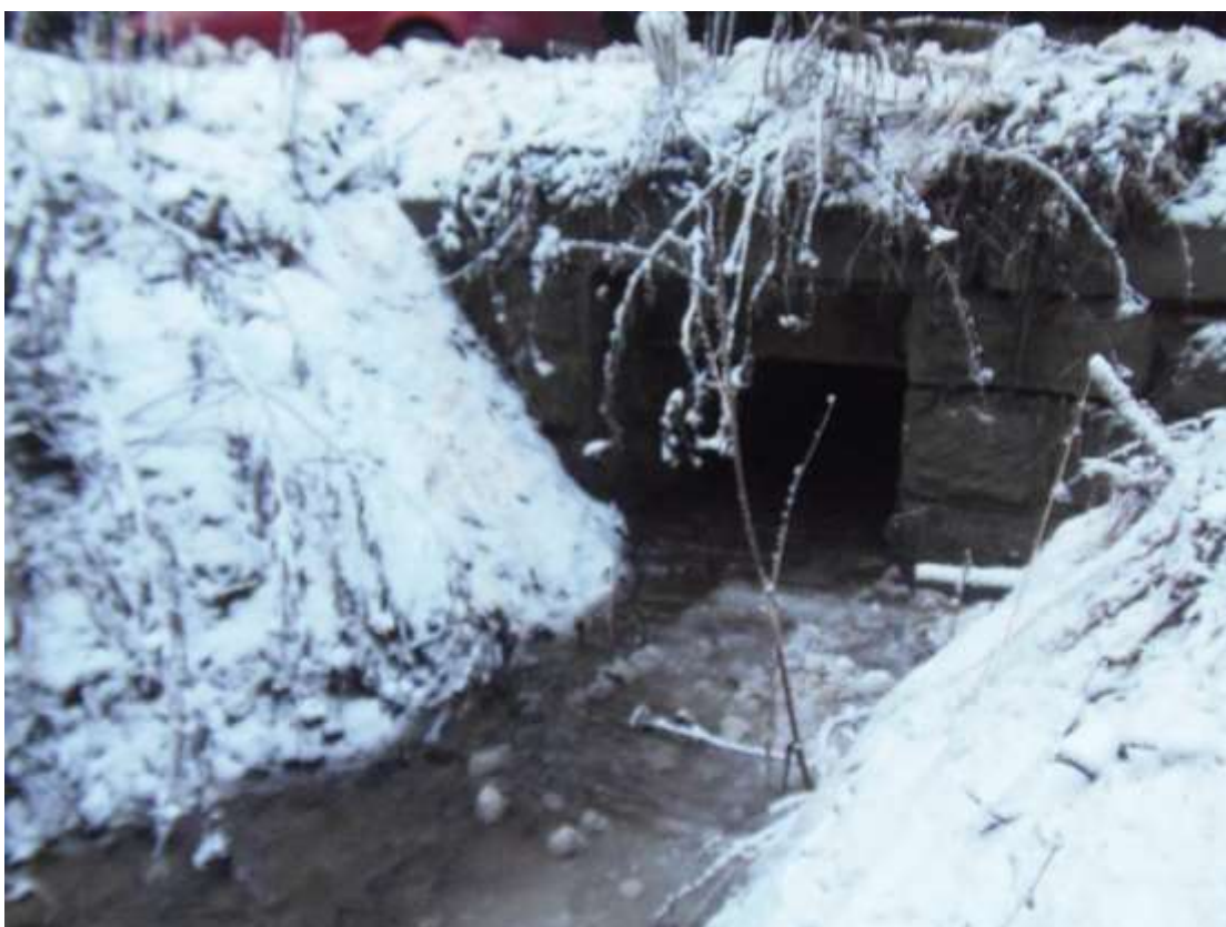
Foto. 4 - Vedere elevatie aval de podet
