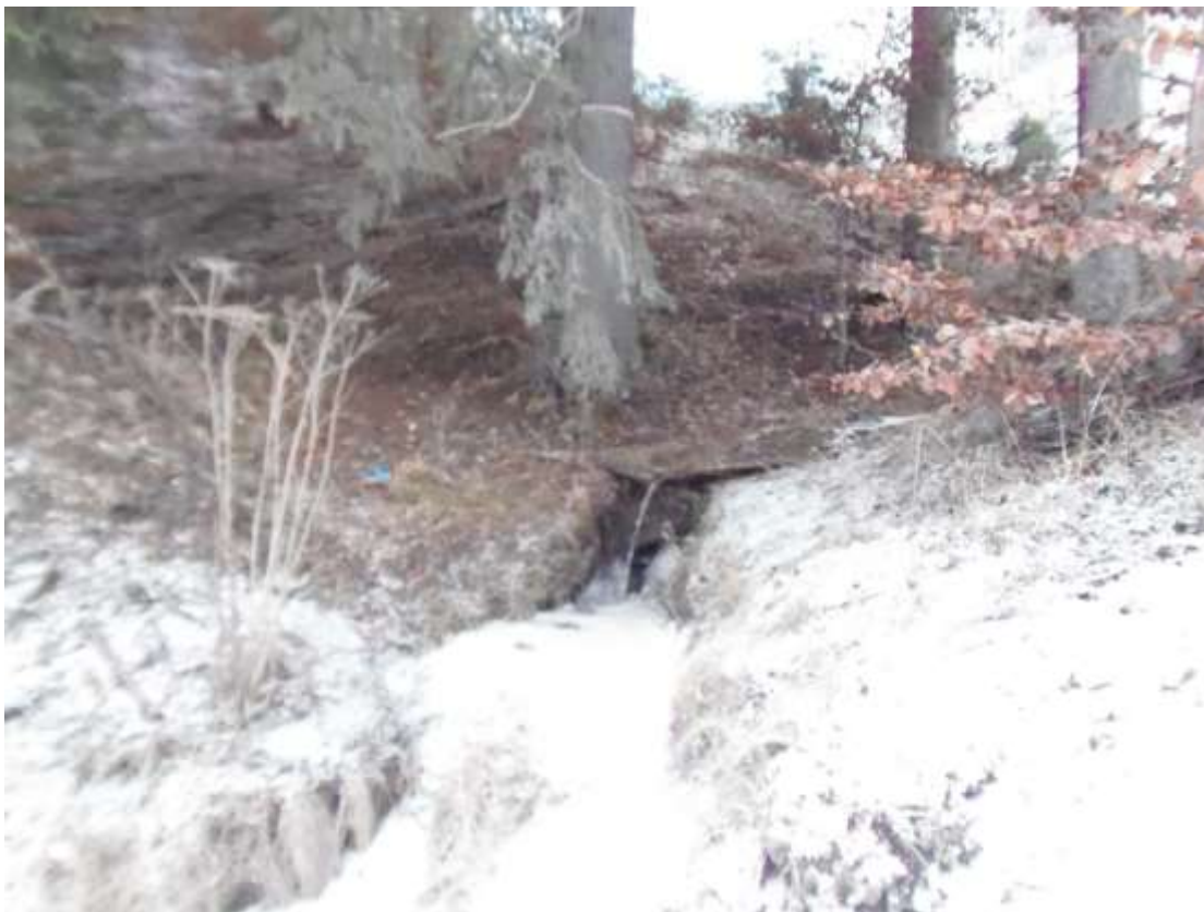
Foto. 3 – Vedere albie amonte de podet
