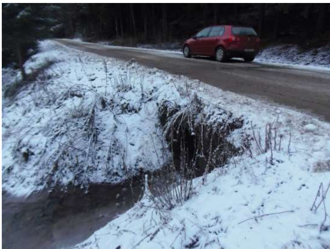
Foto. 2 - Vedere cale pe podet spre Ditrau (E 578)
