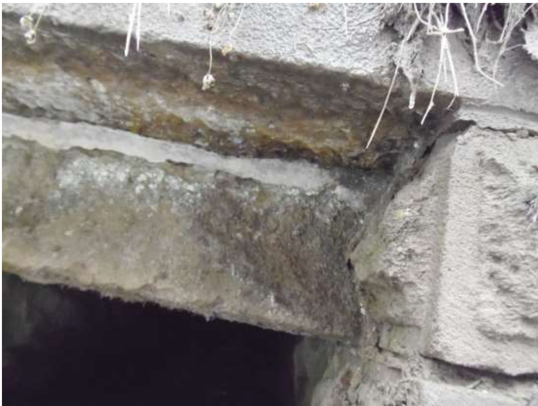
Foto. 7 - Vedere elevatie culee si suprastructura podet – mal stang
